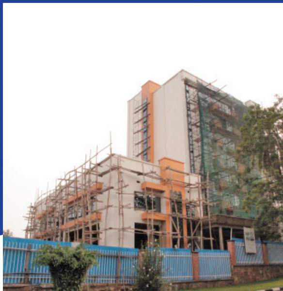
НОВАТА СГРАДА НА ЦЕНТРАЛНОТО УПРАВЛЕНИЕ НА СЪЮЗА В УРАНДА: в строителство в Кигали.
